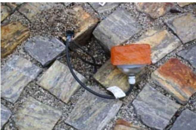
5. Kabel mit Blockklemme verschrauben
